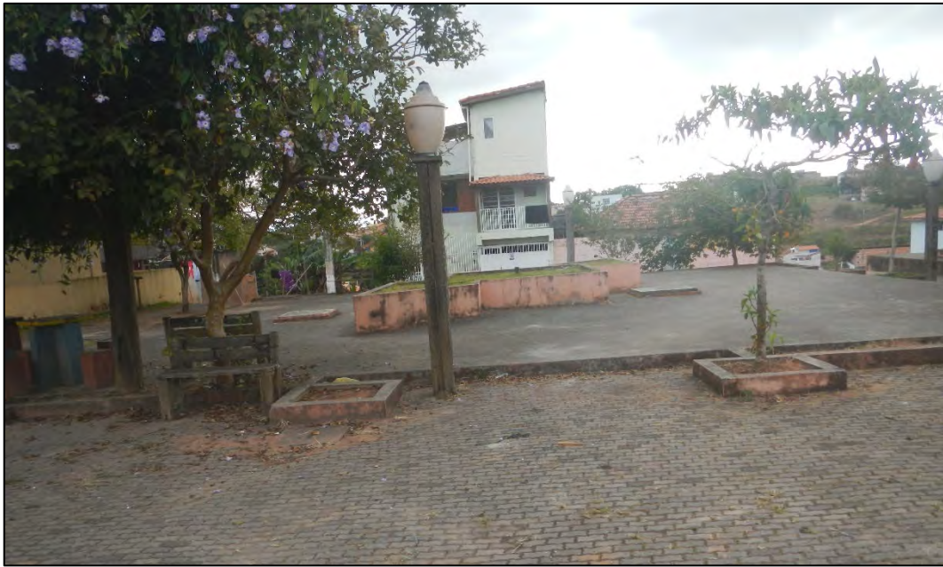
Figura 3-34 – Praça Localizada Acima do Reservatório Areão.
