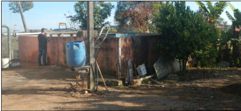
Figura 3-42 – Reservatório Campos de Cunha 001.
