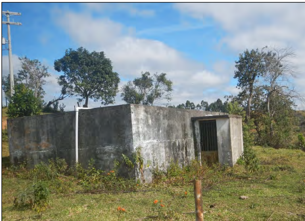
Figura 3-45 – Vista Lateral do Reservatório Campos de Cunha 002.
