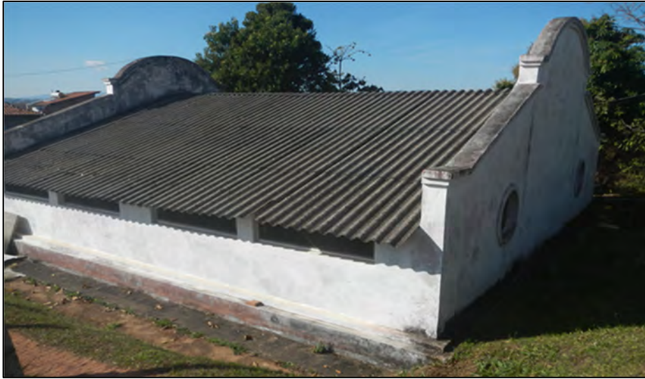
Figura 3-28 – Vista Lateral do Reservatório Alto do Cruzeiro 002/Capela.
