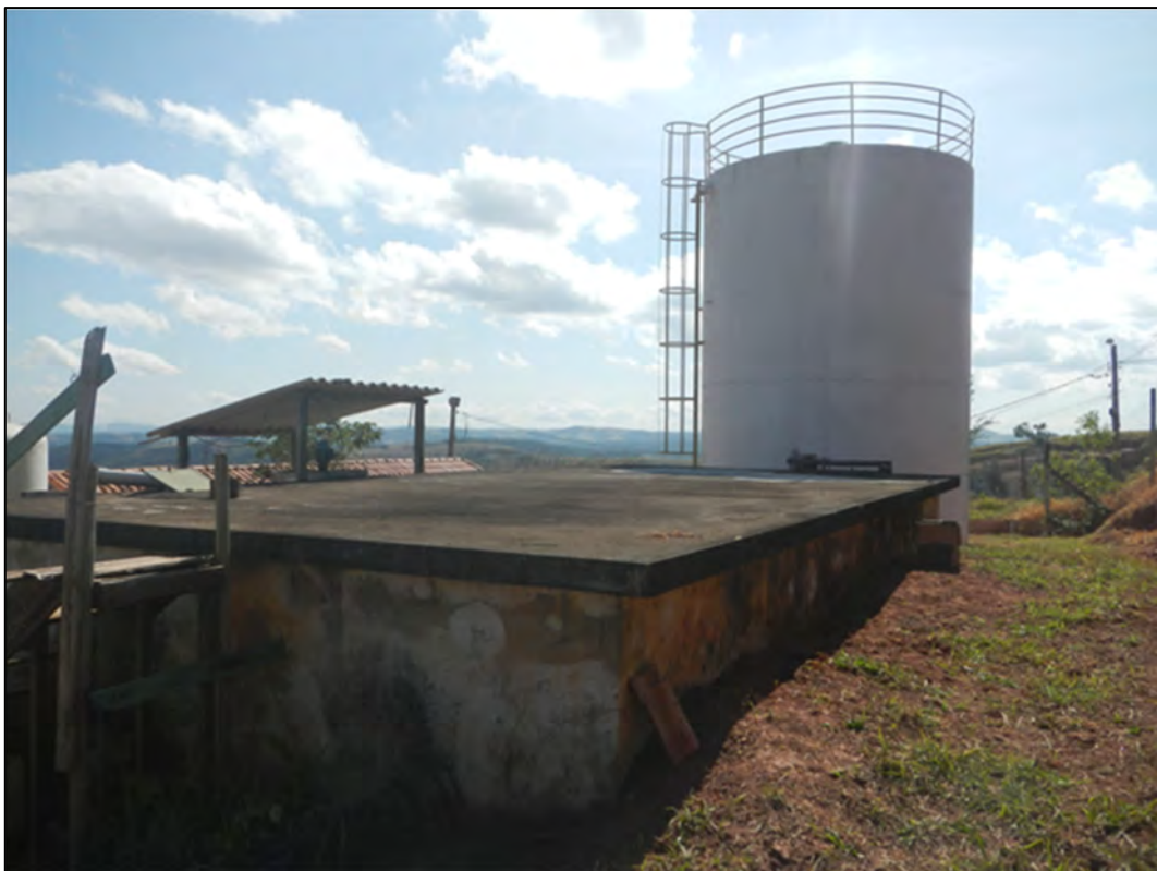
Figura 3-35 – Reservatórios Parque Nova Cunha 001 (A Frente) e 002 (Atrás).
