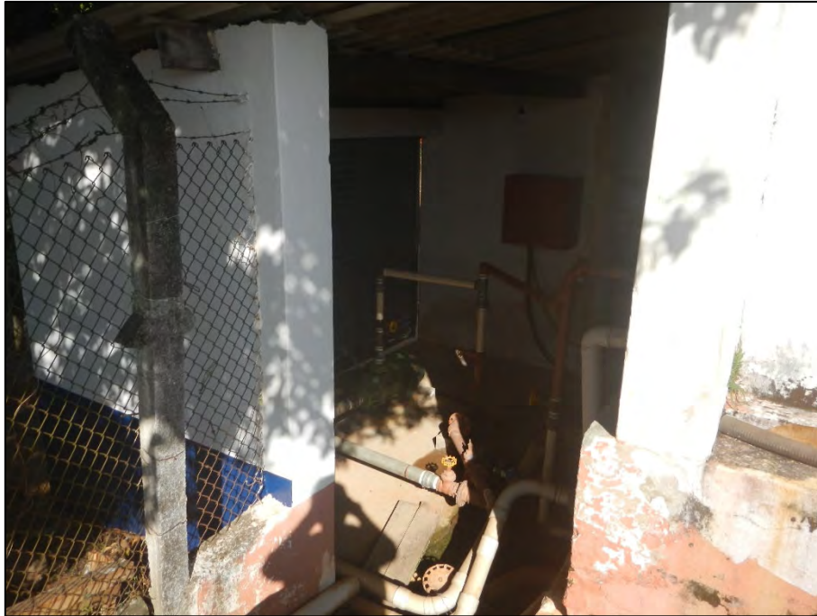
Figura 3-23 – Entrada das EEATs Cajuru e Nova.
