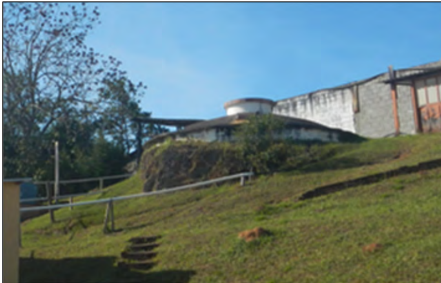
Figura 3-26 – Vista geral do Reservatório Alto do Cruzeiro 001.
