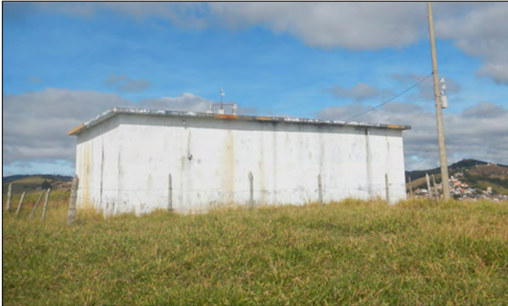
Figura 3-40 – Reservatório Alto do Jovino.
