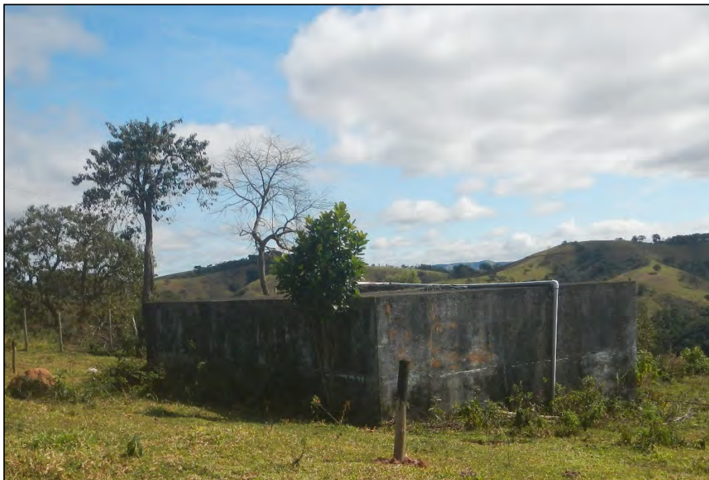
Figura 3-44 – Vista Geral do Reservatório Campos de Cunha 002.
