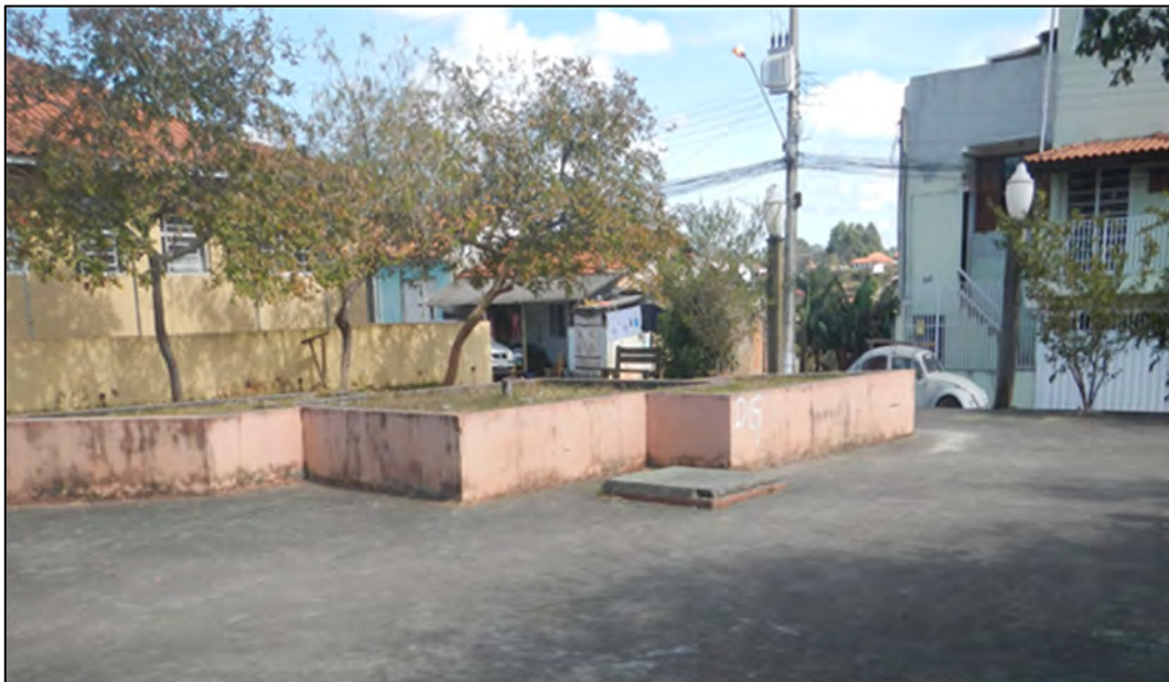
Figura 3-33 – Vista Geral do Reservatório Areão.
