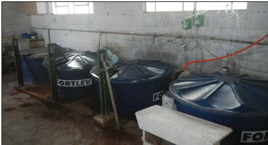
Figura 3-20 – Tanques de Preparo e Homogeneização de Produtos Químicos – ETA Parque Nova Cunha.
