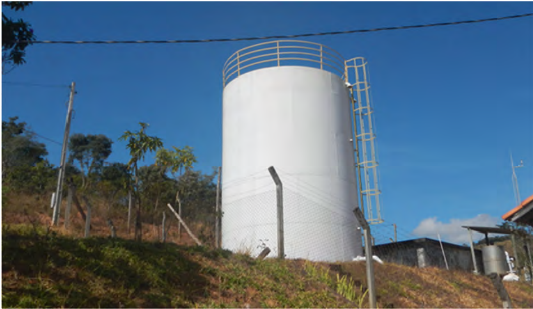
Figura 3-36 – Reservatório Parque Nova Cunha 002.
