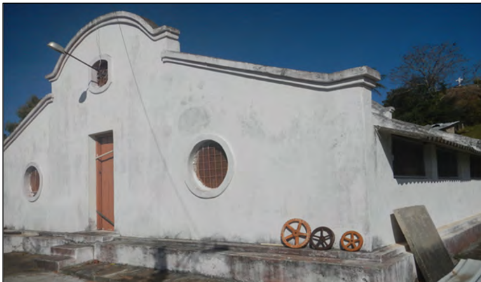
Figura 3-27 – Vista da Fachada do Reservatório Alto do Cruzeiro 002/Capela.
