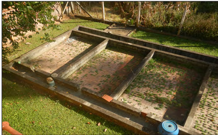
Figura 3-49 – Leito de Secagem do Lodo Gerado no Sistema.
