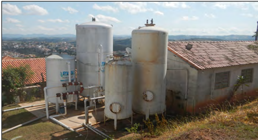
Figura 3-19 – Vista Geral – ETA Parque Nova Cunha.
