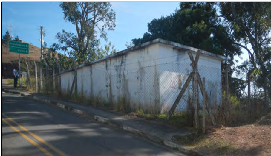
Figura 3-31 – Vista Inferior - Reservatório Alto do Cajuru.
