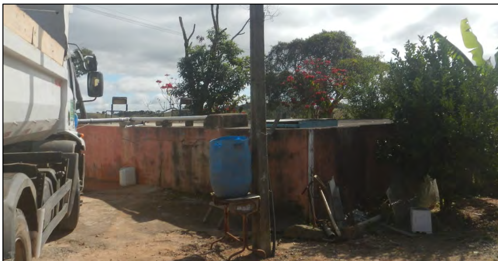
Figura 3-43 – Reservatório Campos de Cunha 001.
