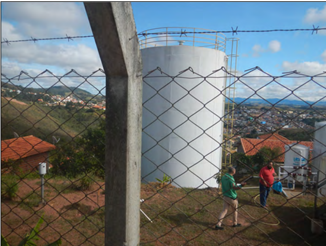
Figura 3-37 – Reservatório Parque Nova Cunha 003.
