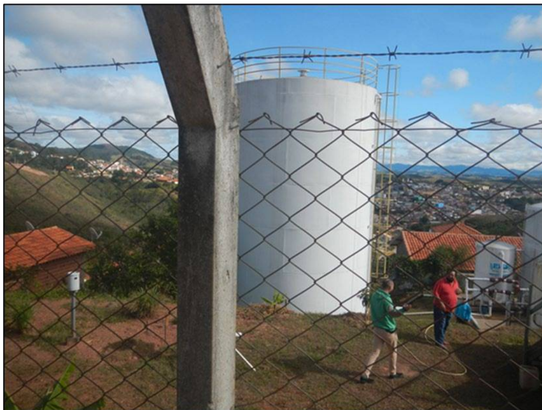
Figura 56 - Reservatório Parque Nova Cunha 003.
