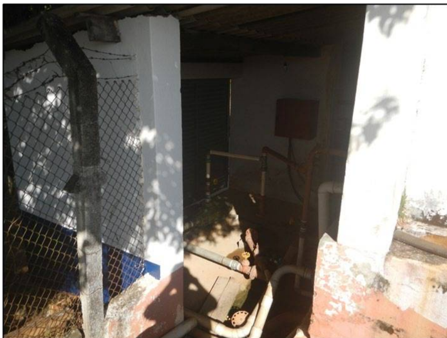
Figura 42 - Entrada das EEATs Cajuru e Nova.
