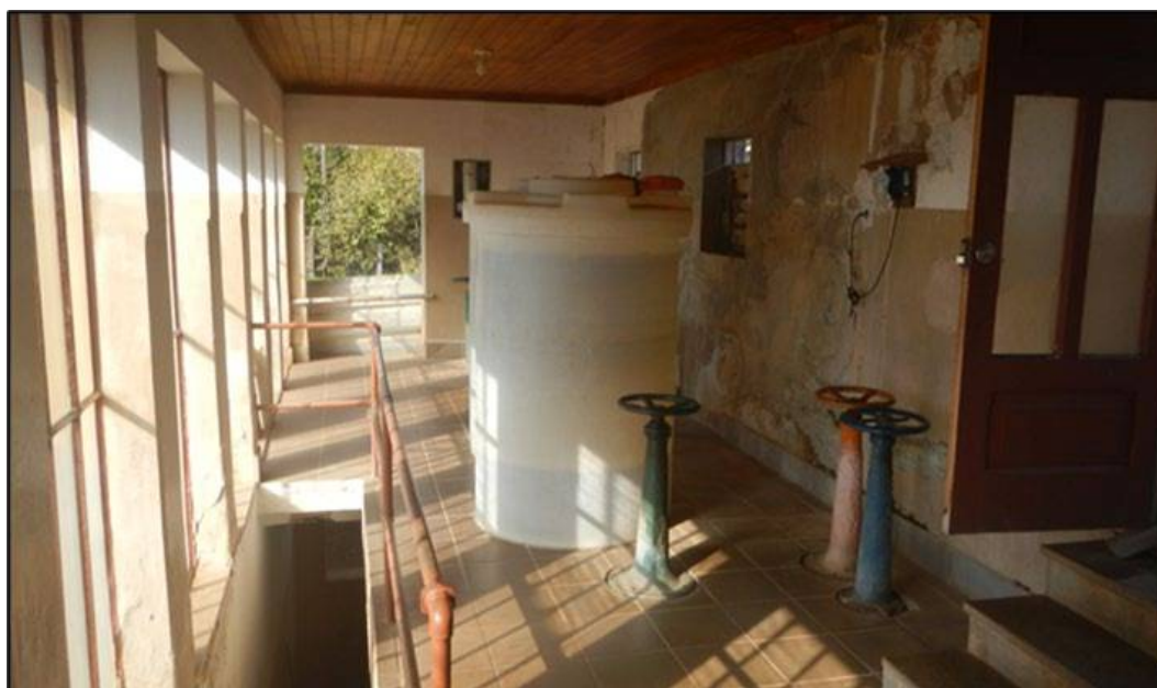
Figura 37 - Produtos Químicos Armazenados.
