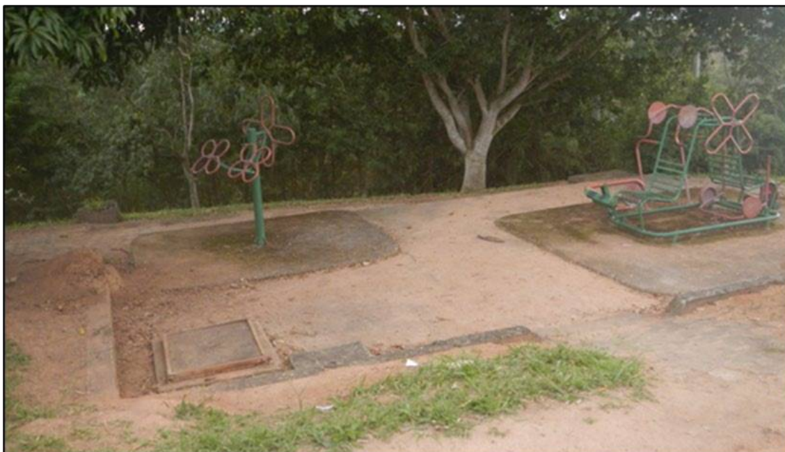
Figura 51 - Vista Superior - Reservatório Vila Rica.
