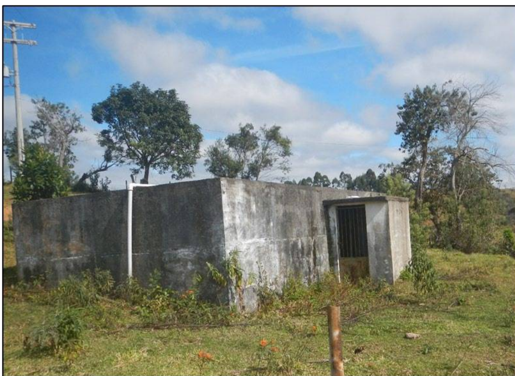
Figura 64 - Vista Lateral do Reservatório Campos de Cunha 002.
