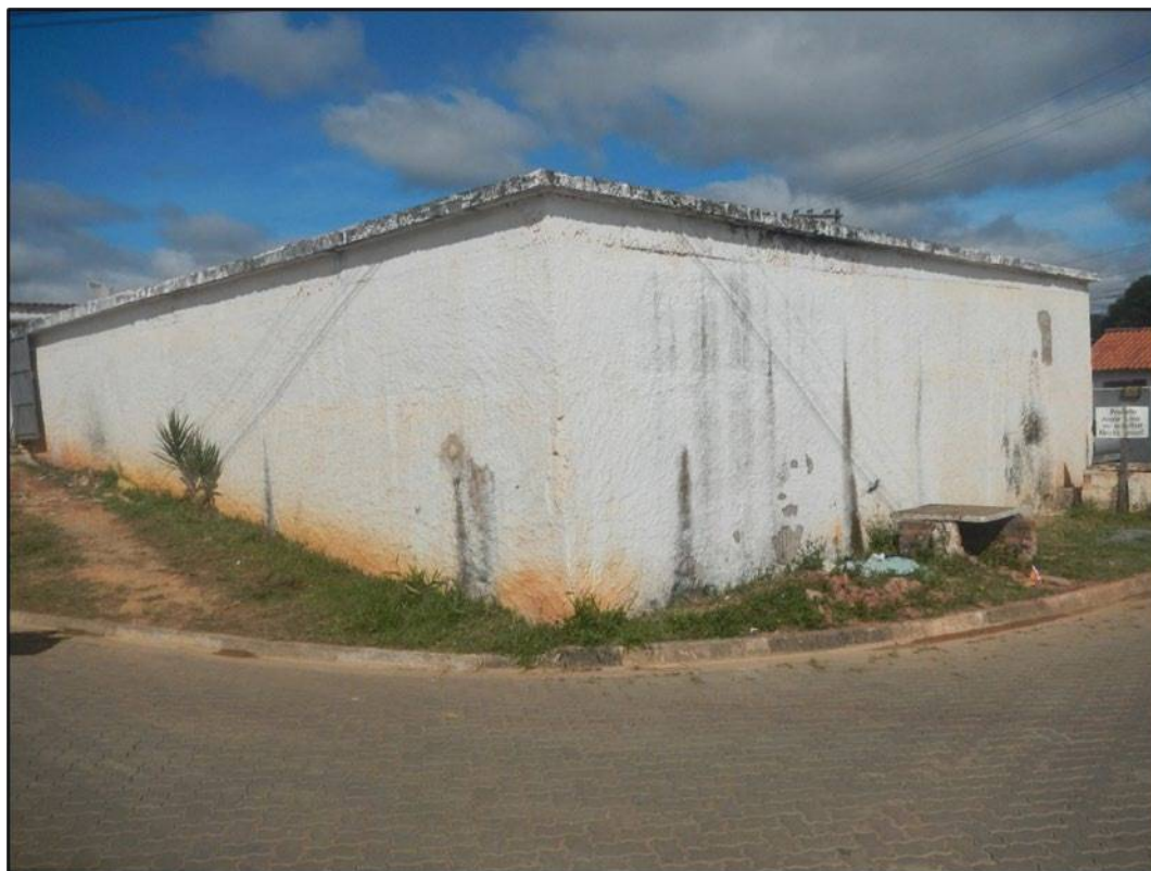
Figura 58 - Reservatório Alto do Gouveia.
