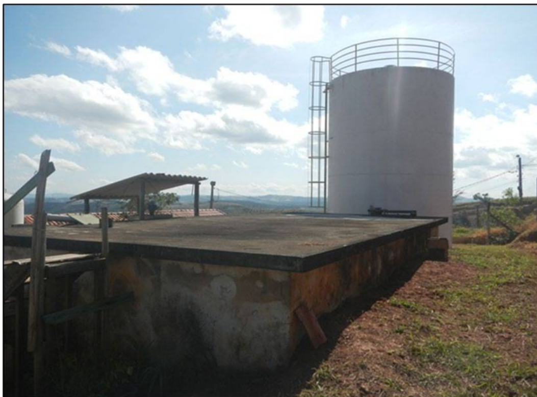
Figura 54 - Reservatórios Parque Nova Cunha 001 (A Frente) e 002 (Atrás).
