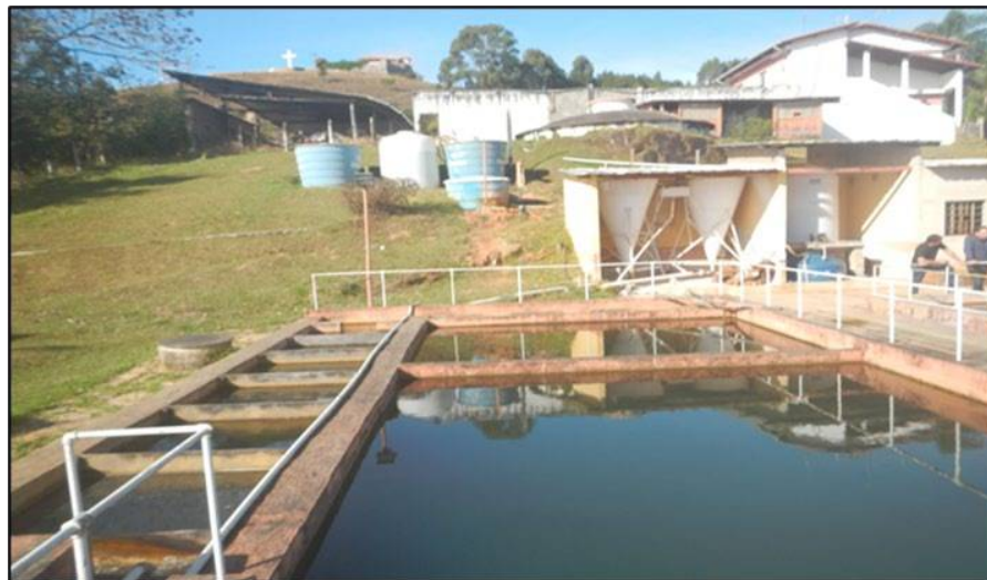
Figura 35 - Vista Geral – ETA Alto do Cruzeiro.
