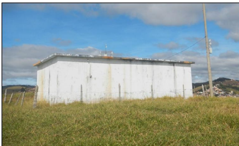
Figura 59 - Reservatório Alto do Jovino.
