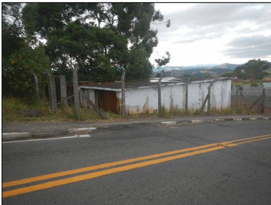
Figura 49 - Vista Superior - Reservatório Alto do Cajuru.
