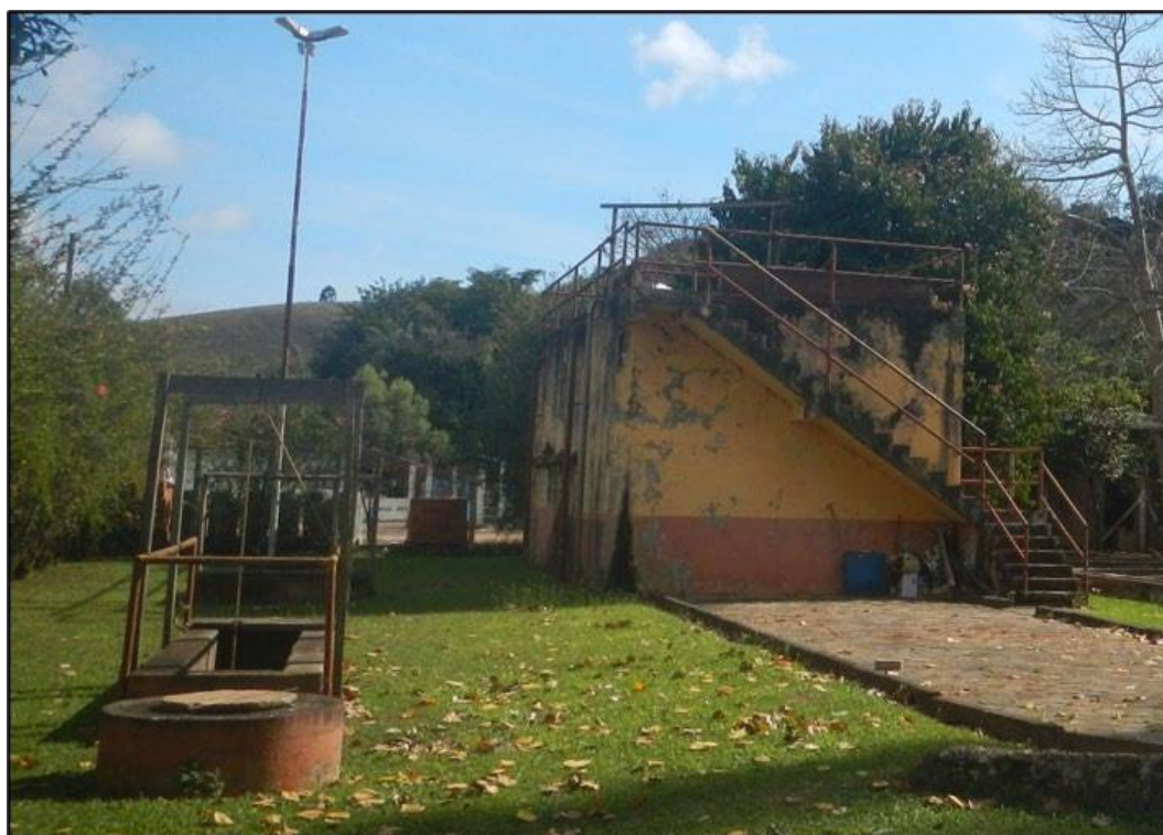
Figura 66 - Vista Geral da ETE Campos de Cunha.
