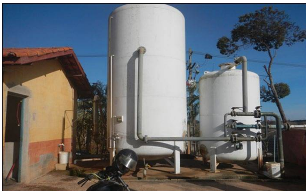
Figura 40 - Vista Externa – ETA Campos de Cunha.
