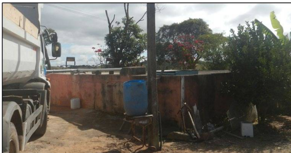
Figura 62 - Reservatório Campos de Cunha 001.
