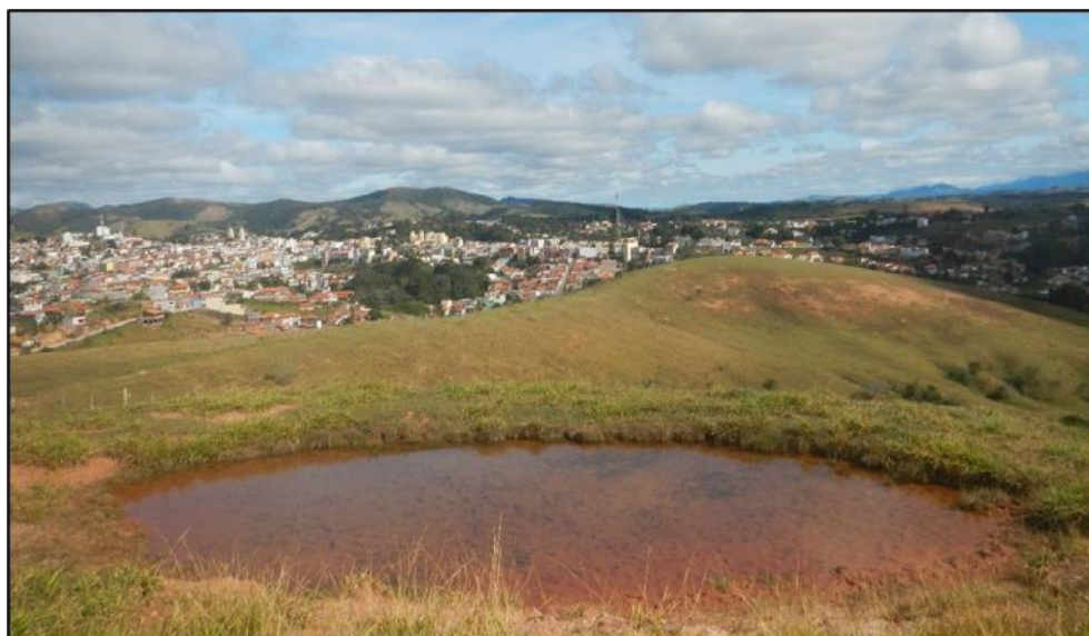
Figura 60 - Poça Gerada Na Parte Baixa do Terreno Devido a Vazamento do Reservatório.
