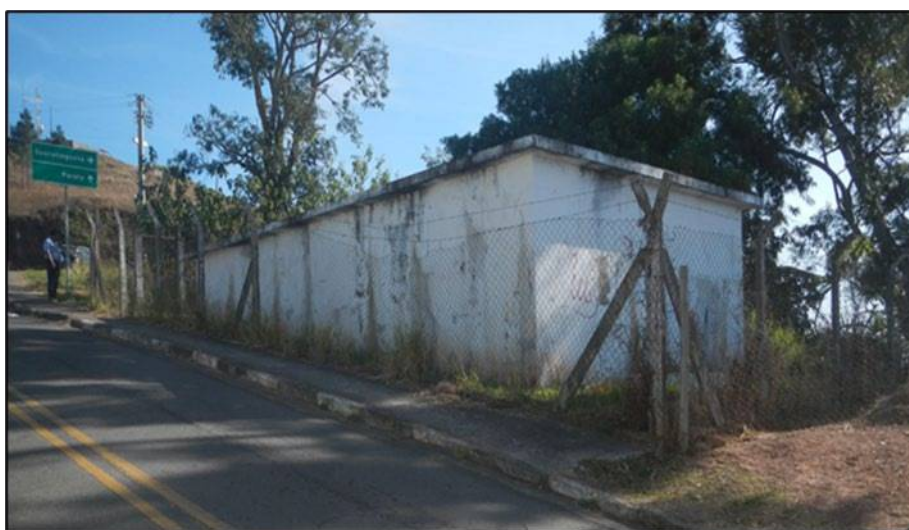
Figura 50 - Vista Inferior - Reservatório Alto do Cajuru.
