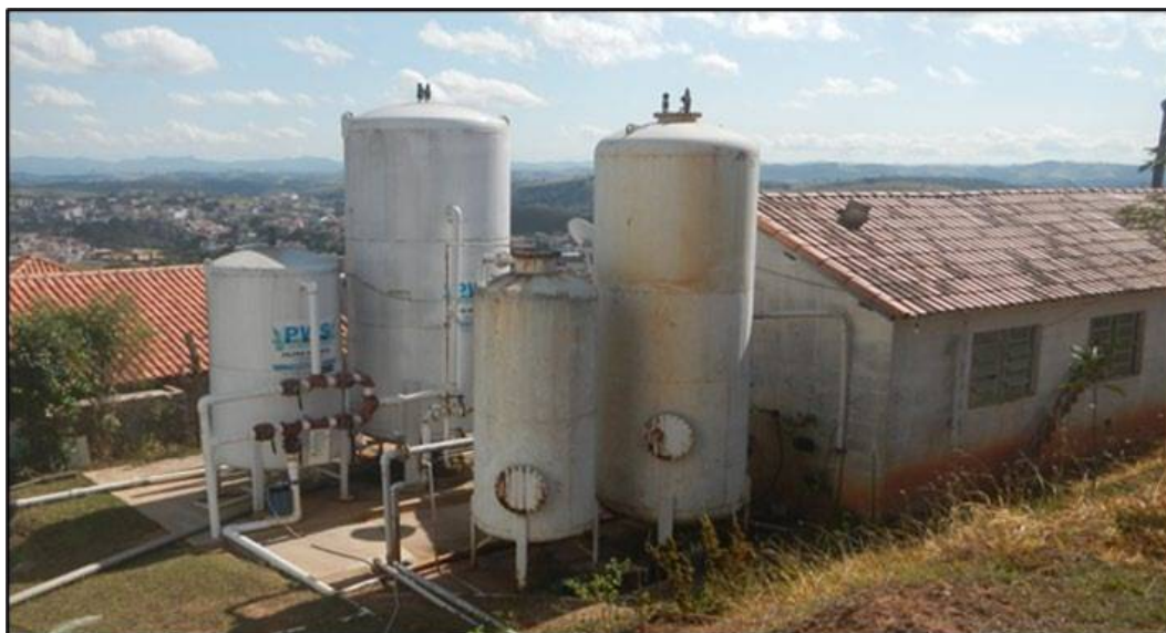
Figura 38 - Vista Geral – ETA Parque Nova Cunha.
