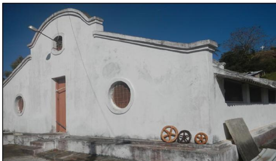
Figura 46 - Vista da Fachada do Reservatório Alto do Cruzeiro 002/Capela.
