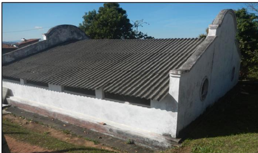
Figura 47 - Vista Lateral do Reservatório Alto do Cruzeiro 002/Capela.
