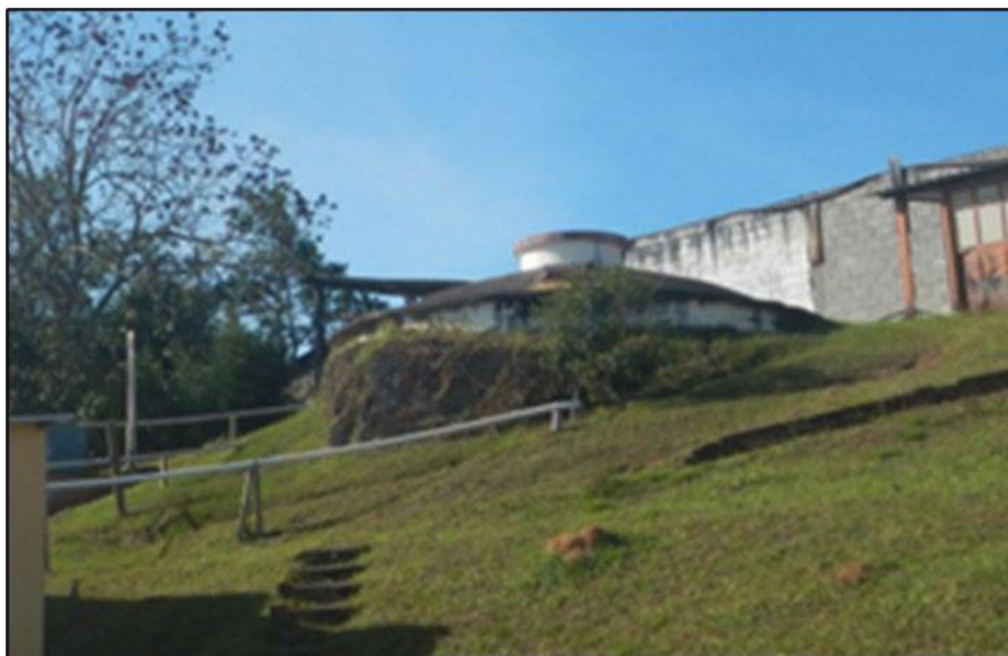
Figura 45 - Vista geral do Reservatório Alto do Cruzeiro 001.
