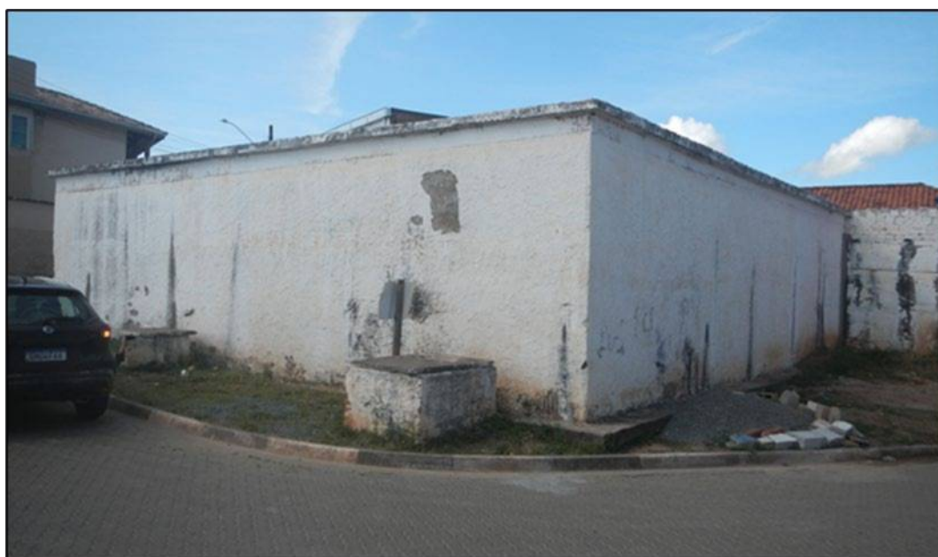
Figura 57 - Reservatório Alto do Gouveia.
