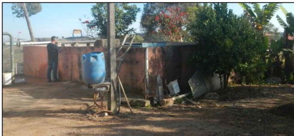
Figura 61 - Reservatório Campos de Cunha 001.
